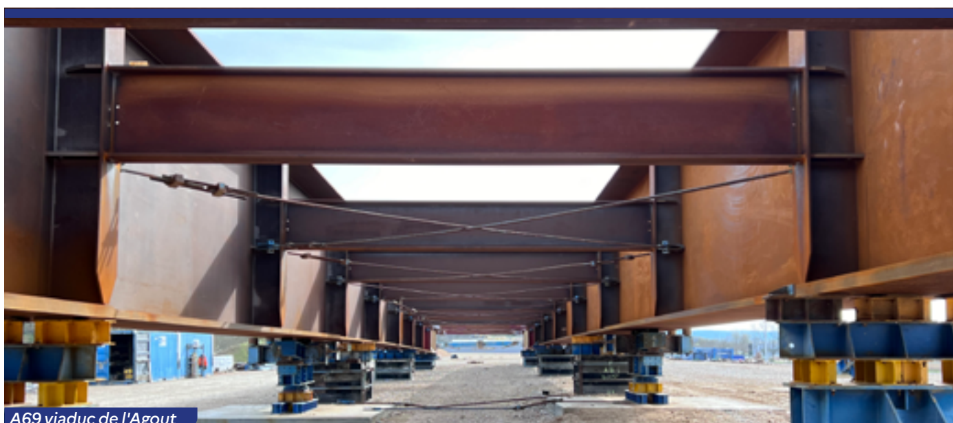
A69 viaduc de l'Agout
