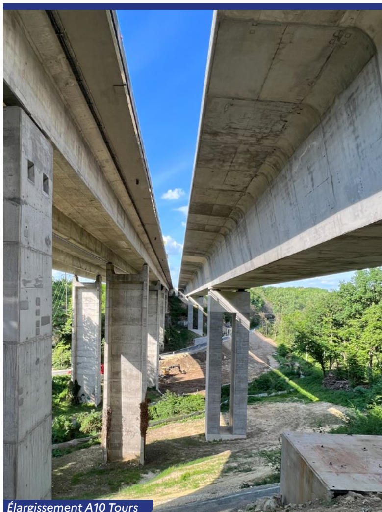
Élargissement A10 Tours
